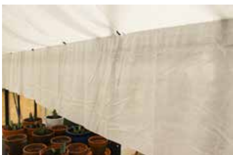
Système d'ombrage Beschattungssystem Shading system
