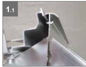
1.1 Pose de la lucarne sur faitière par glissement
