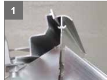
Pose de la lucarne sur faîtière par glissement. Anbringung des Fensters auf First durch Gleiten. Installing the window on roof ridge through sliding.
