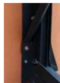
Fixation au mur à travers le profil de la serre
