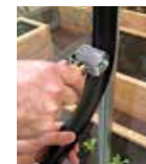
Pose du joint
